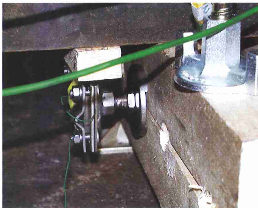
Bild 10: Kreuzklemme am linken Anschluss mit Temperaturmessstelle T1 (Versuch 122-02/108)
