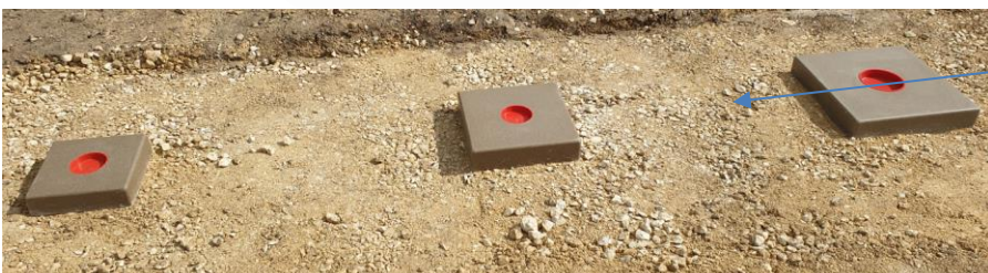
Auffüllen und verdichten bis Geländeoberkante
