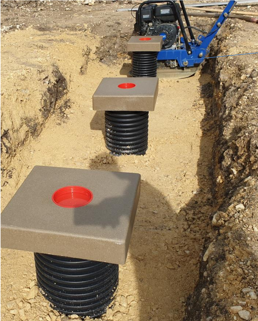
Verdichtung mit Rüttelplatte
