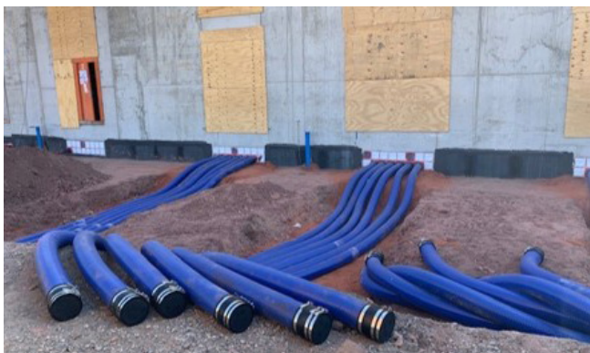
Hateflex 螺旋软管具有外形稳定性、耐扭曲性、可在穿线管系统上方施工建造、耐候及耐紫外线等特性，因此是电缆安全和顺利铺设的最佳解决方案。
