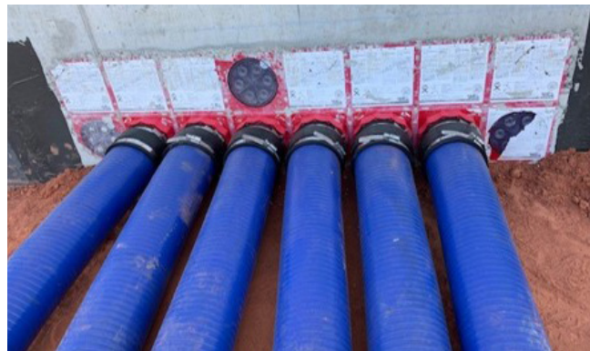
Hateflex 软管与填料密封装置则通过 KES MA150 D 系统盖连接。
