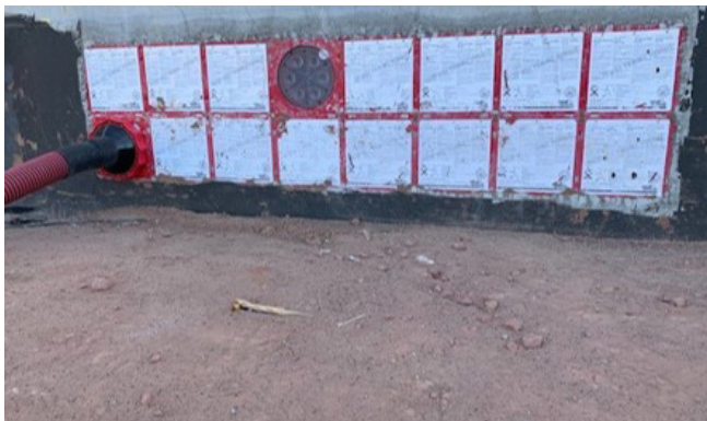
带双侧填料密封装置的 HSI150 K2/x 电缆引入装置的使用数量考虑了足够的备用开口数量。
