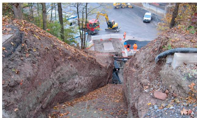
Bedingt durch die Topographie des Geländes wurde teilweise auch mit den flexiblen Kabeleinführungssystemen KES 150 / Hateflex 14150 gearbeitet, um die Anbindung der Rohre zu ermöglichen.
