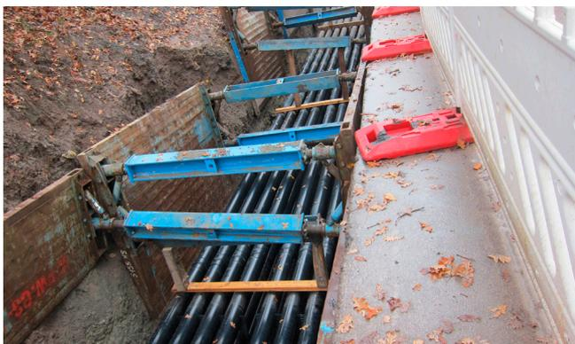
Die Gräben der Leerrohrtrassen wurden mit Flüssigboden verfüllt. Hierzu wurden die Rohrpakete gegen Auftrieb gesichert.
