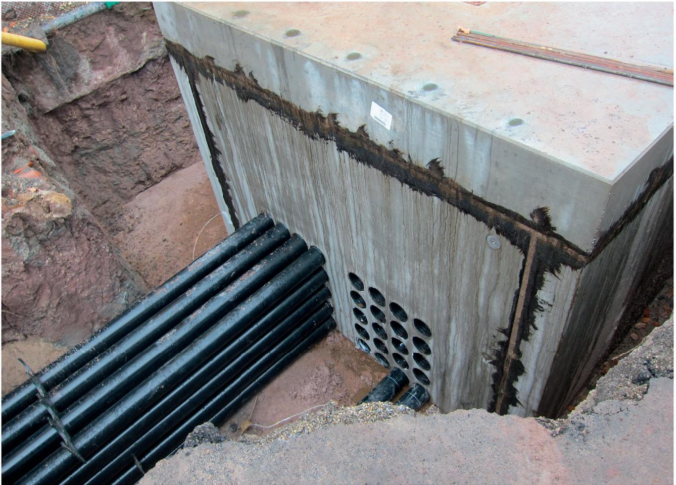
KABELDURCHFÜHRUNG MIT GUMMISTECKMUFFE HSI 150-GSM 160
