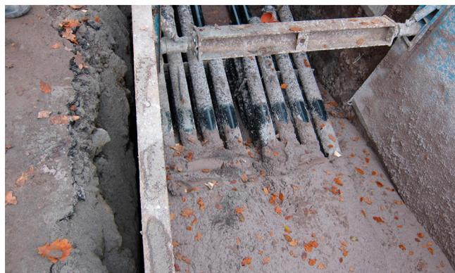
Verfüllung der Leerrohrtrasse mit Flüssigboden. Dadurch wird sichergestellt das alle Zwickelbereiche zwischen den Kabelschutzrohren mit Boden ausgefüllt sind.
