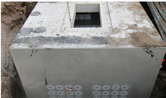
Die Dichtpackungen HSI 150-GSM 160 mit integrierter Gummisteckmuffe wurden bereits beim Schachthersteller eingebaut. Durch die Paketanordnung wird eine hohe Belegungsdichte zum Anschluss von Kabelschutzrohren erreicht.
