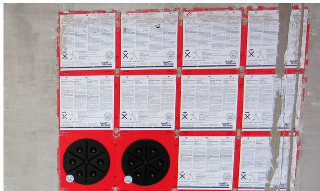
Unbelegte Durchführungen sind mit dem druckdichten Verschlussdeckel HSI 150-D blind verschlossen und verhindern einen möglichen Wassereintritt über die Leerrohrtrasse.
