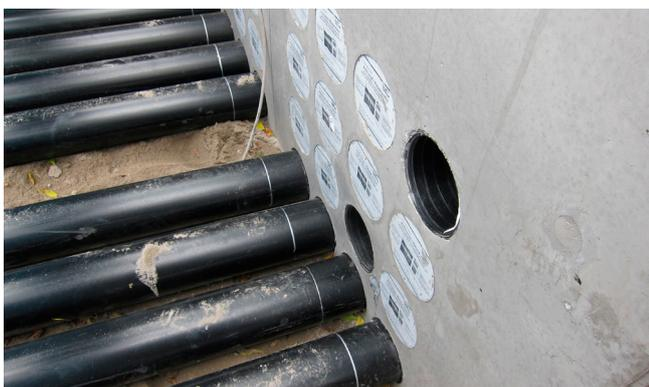
Die glatten Kabelschutzrohre Da= 160 werden montagefreundlich über die Gummisteckmuffe druckdicht an den Schacht angeschlossen.
