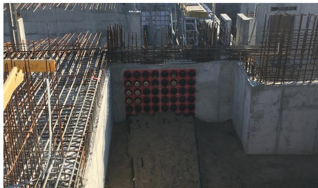
Da 160 mm 的光滑电缆保护管连同 HSI150 M168 系统盖分层连接至电缆穿入装置。照片中展示的是电缆保护管的第一层。
