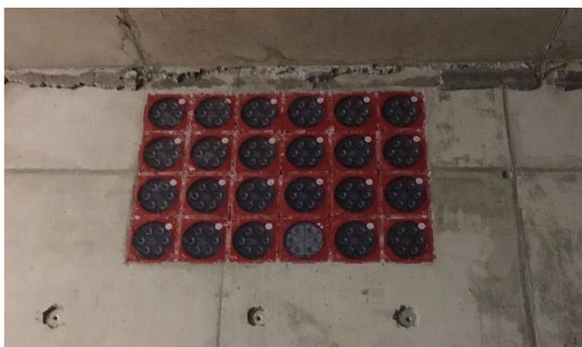
未铺设的电缆穿入装置已采用 2 bar 的负压封闭密封。通过透明的 HSI150 DT 封闭盖可以随时辨别电缆穿入装置及保护管中是否有水。
