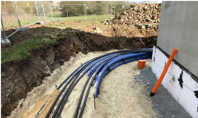
HateBex 螺旋软管通过 KES150-2x3 KA 间隔架可实现精准固定, 达到最佳的地面密封效果并且便于后续的电缆铺设。
