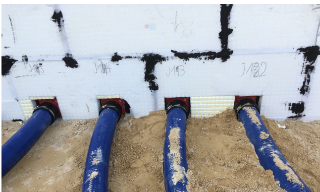
HateBex14150 螺旋软管通过橡胶密封套技术与混凝土固定的 HSI150 电缆引入装置实现气密和水密性连接。
