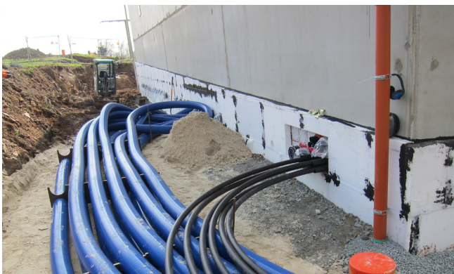
具有优秀抗弯曲强度的 HateBex14150 电缆保护管系统能够承受机械压力, 满足相应的弯曲半径指标。
