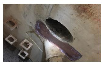
Vor dem Einsetzen des Flansches sieht man Austrittstellen der Kabel-Leitungsführungen zum Maschinenraum und zum Steigschacht.
