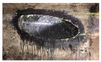
Zustand des Dükers im Abwasserkanal vor der Montage der Edelstahlflanschplatte: schräge Kernbohrungen Ø 250 mm mit Gefälle zur Führung der neuen Energie- und Datenkabel direkt an der Betonröhrenwandung (1,80 m Abwasserkanaldurchmesser).
