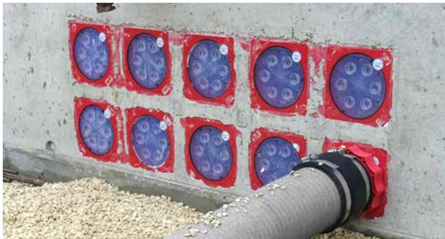
KES MA150 D und Spiralschlauch Hateflex14150
