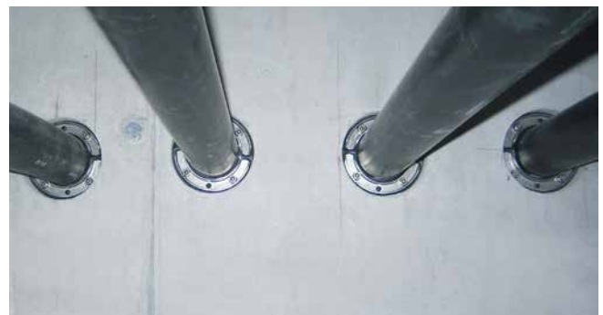
HSD125 1x75 b20 A2/EPDM55 empty conduit connection
