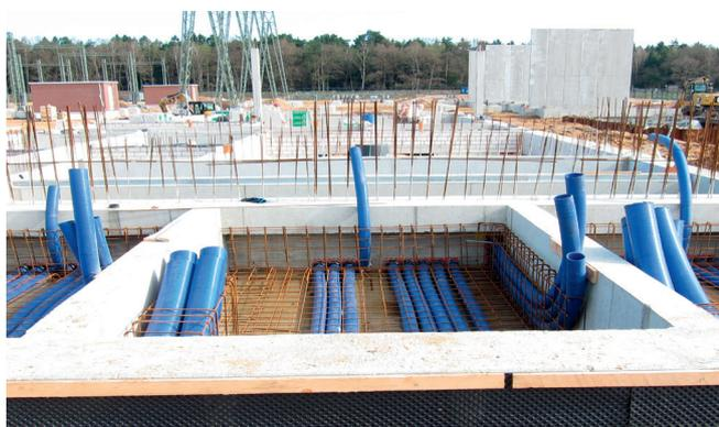
Verlegung der Schläuche und Anschluss an die Dichtpackungen mittels Manschettentechnik.
