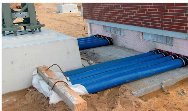
Die KES-Systeme 14150 wurden mittels Manschettentechnik an die einbetonierten Dichtpackungen HSI 150 angeschlossen.
