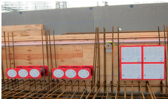
Dichtpackungen HSI 90 und HSI 150 sowie Erdungsdurchführungen wurden in die Schalung eingebaut.
