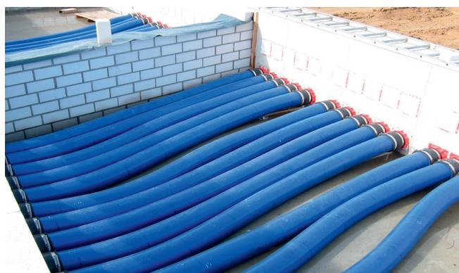
Die KES-Systeme 14090 wurden mittels Manschettentechnik an die einbetonierten Dichtpackungen HSI 90 angeschlossen.
