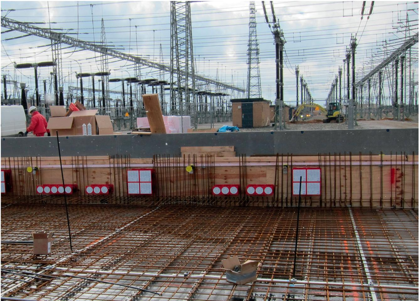
WASSERDICHTHE KABELINFÜHRUNGEN IN GESCHLOSSENEN SYSTEMEN
