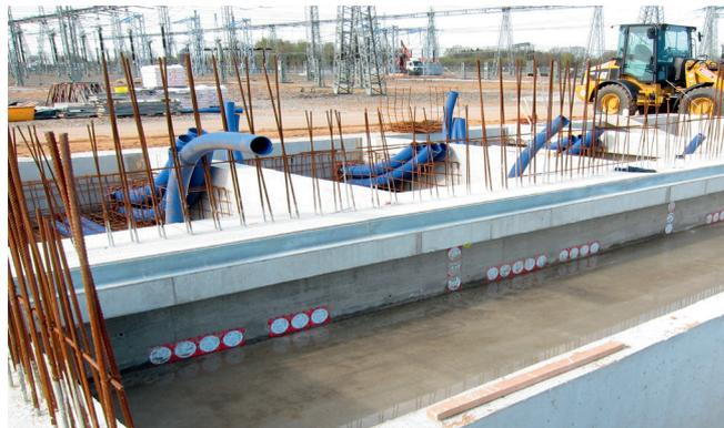
Verlegung der flexiblen Kabeleinführungssysteme KES-M 150 mit Hateflex 14150 und KES-M 90 mit Hateflex 14090.
