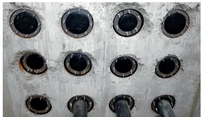
Mit universellen Dichtelementen werden Standardöffnungen mit individuellen Kabelbelegungen einfach, schnell und sicher abgedichtet.
