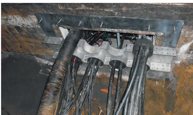
Abschnittweise Flanschplattenmontage mit Langschaftdübel und Edelstahlsschrauben.
