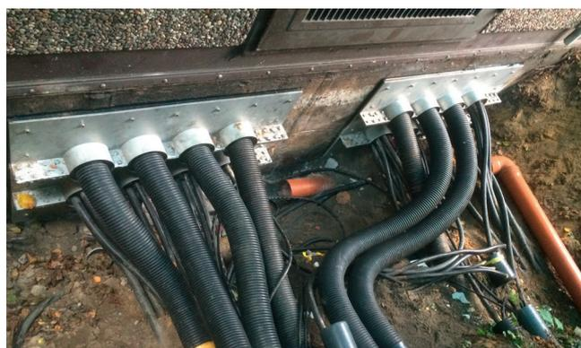
Neue Wanddurchführung mit Kabel- und Schutzrohrgraben vor dem Wiederverfüllen.
