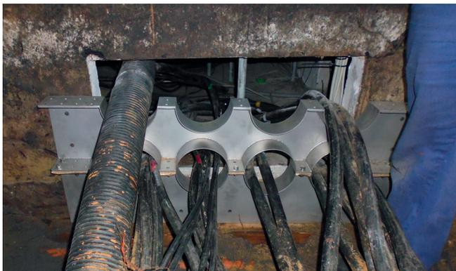
Setzen der vormontierten Flanschplatten und Kennzeichnung der Montagepositionen vor der Wanddurchführung.
