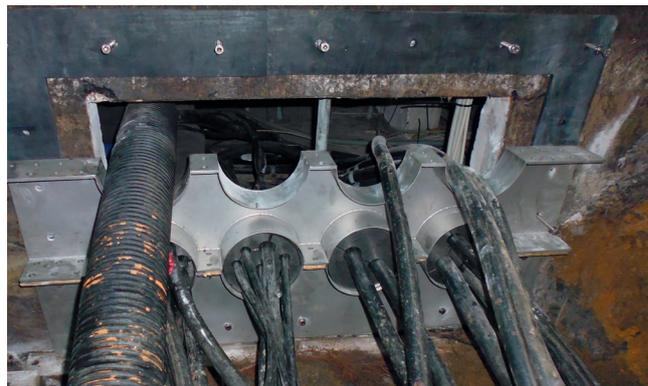
Flachdichtung mit Sikaflex Dichtmasse an der Wand aufgeklebt.
