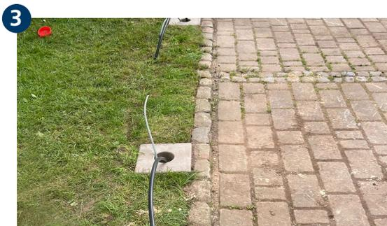
Der Graben und ULF wird mit Erde/ Kies aufgeschüttet und fachgerecht verdichtet.
