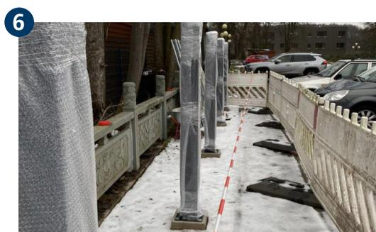
Für die Zukunft gewappnet: Austausch oder Wechsel der Ladesäulen ist nun ohne erneutes Aufgraben möglich. Auch eine andere Ladesäule kann im Austausch problemlos, durch Bohren von neuen Befestigungslöchern, montiert werden.
