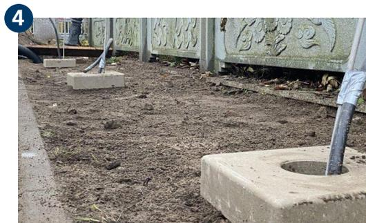
Das universelle Ladesäulenfundament ist witterungsbeständig und stellt somit die spätere Installation der Ladesäulen sicher.
