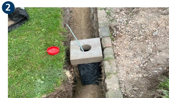
Dadurch ist keine Straßensperrung notwendig und die Zuwegung wird nicht durch Baufahrzeuge beschädigt. Die Blindverschlussdeckel können die eingezogenen Kabel bis zur späteren Installation der Ladesäulen vor Regen und Nässe schützen.
