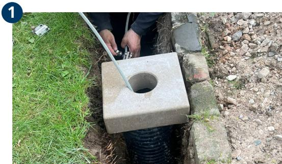
Durch das geringe Gewicht ist die einfache Positionierung des ULF im Graben möglich. Strom- und Datenkabel werden durch das Leerrohr und das Fundament gezogen. Es wird keine große Technik (z.B. Ladekran) zur Platzierung der Fundamente benötigt.
