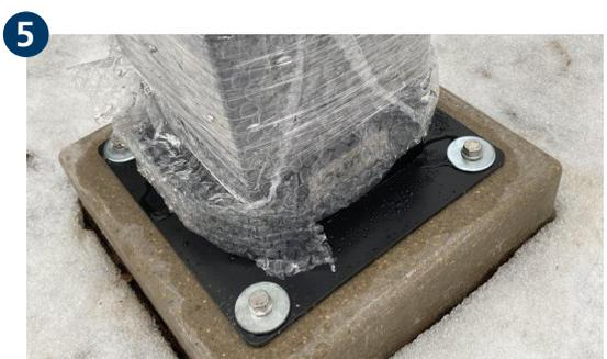
Installation von Ladesäulen: Einfache Montage ist garantiert, da die Fundamentplatte aus Polymerbeton angebohrt werden kann.
