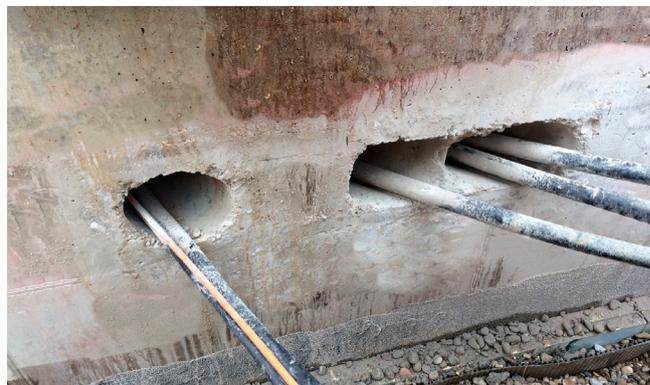
Besonderheit: Die Kabel treten in unterschiedlichen Winkeln in den Medienkanal ein und aus. Die Lage der Kabel kann nicht verändert werden.
