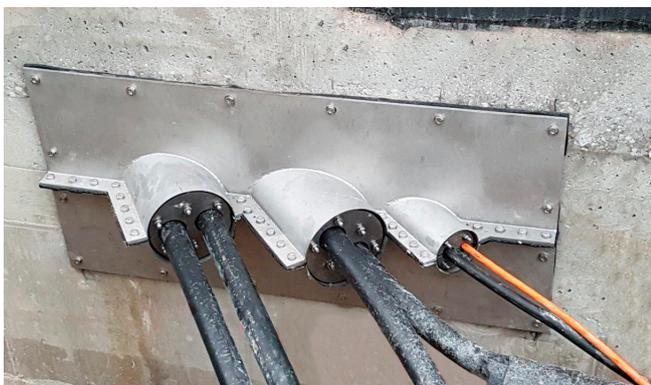
Lösung: Aufmaß eines Vorbauflansches in geteilter Ausführung mit unterschiedlichen Rohrstützenabgängen entsprechend dem Austrittswinkel der Kabel.
