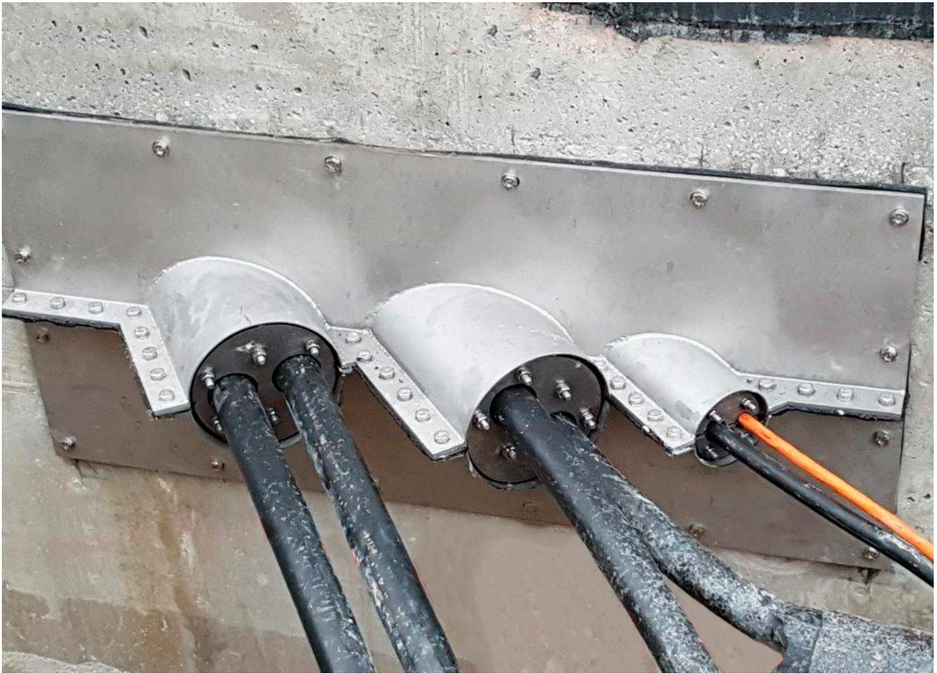
KABELDURCHFÜHRUNG MIT DEM EDELSTAHLFLANSCH HRD2X150-1X80
