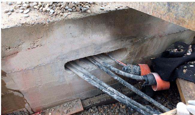
Bestehende Hauptversorgungsleitungen konnten im Zuge der Erstellung eines begehbaren Medienkanals nicht umverlegt werden. Während der Baumaßnahme wurde eine Aussparung um die Kabel frei gelassen.
