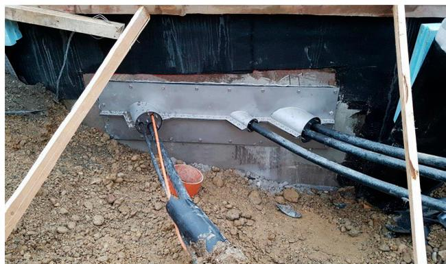
Bild: Kabelaustritt aus dem Medienkanal
