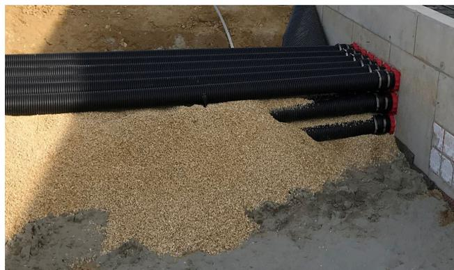
HSI 150 填料密封装置上已完成安装的保护管。
