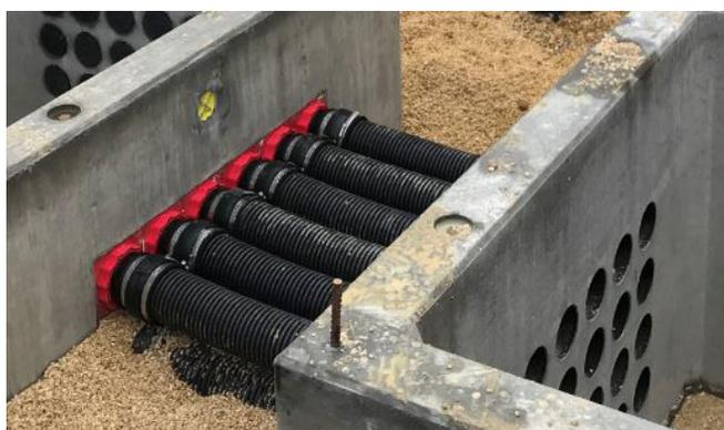
采用出厂时已安装好的 HSI 150 填料密封装置、保护管以及我们的 HSI 150 – M168 WR 系统盖连接各个电缆竖井。
