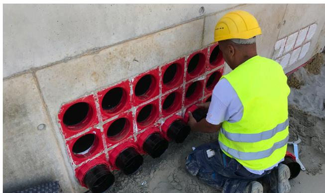
安装 HSI 150 – M168 WR 系统盖，用于后续连接波纹电缆保护管。
