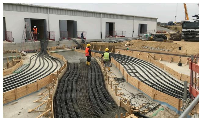
用混凝土浇筑连接新楼房和现有楼房之间的保护管。
