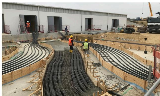
Betonage der Schutzrohrverbindung zwischen Neubau und Bestandsgebäuden.
