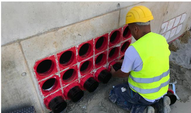
Montage der Systemdeckel HSI 150 – M168 WR zur späteren Anbindung der gewellten Kabelschutzrohre.
