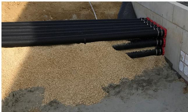
Fertig montierte Schutzrohre an HSI 150 Dichtpackungen.
