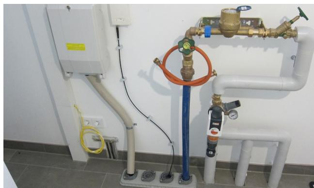
Der Hausanschluss wurde mit der Mehrspartenhauseinführung MSH Basic erstellt.
