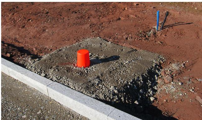
An der Grundstücksgrenze von jedem Bauplatz wird die G-Box mit der Pylone eingesetzt. Das Glasfaser ist bereits eingblasen und der Abschlusspunkt auch schon gespleißt. Das Plug & Play-Kabelsystem Hauff-Quick-Connect wird unter der Pylone abgelegt.
