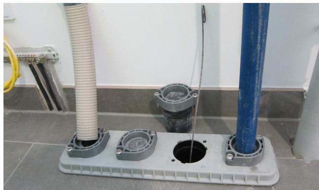
Das Kabelsystem Hauff-Quick-Connect wird über das Leerrohrsystem mit einem Einziehdraht von der G-Box, beziehungsweise der Überlängenbox, eingezogen.
