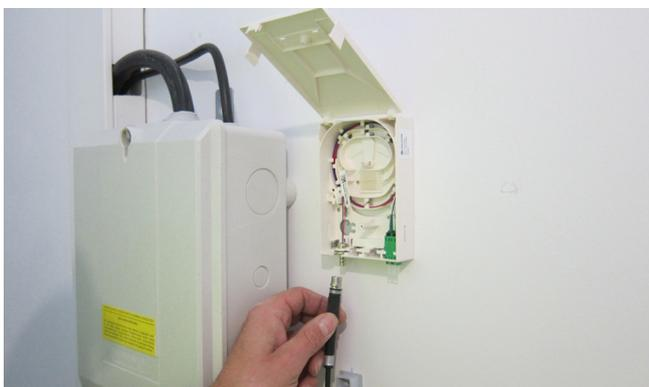
Das Kabelsystem Hauff-Quick-Connect wird mit einem Stecker an den QODC Abschlusspunkt angeschlossen. Abgangsseitig stehen zwei Stück LC/APC Anschlüsse zur Verfügung.
