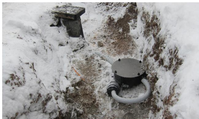
Optional kann die Kabelüberlänge auch im Gelände abgelegt und eine direkte Leerrohrverbindung von der G-Box bis zum Anschlussraum hergestellt werden.
