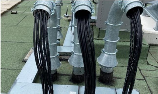
Absolute Fleißarbeit: viele kleine Kabel wurden mit maßgefertigten, geteilten HRD Gummipressdichtungen SKD abgedichtet.
