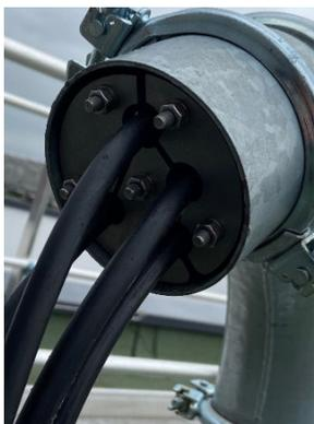
In dieser Detailaufnahme sieht man eine geteilte HRD Gummipressdichtung im Rohrbogen der Schwanenhalsdurchführung (SHD).
